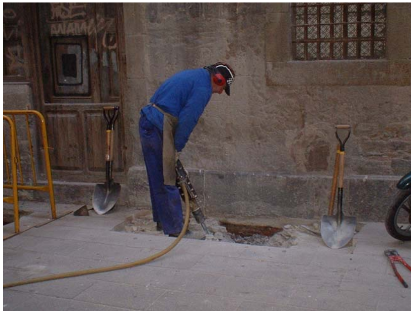
Fotografia 2: Aixecament de les lloses del paviment i la seva base de formigó, amb martell pneumàtic.
